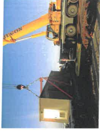
Figure 74 Exemple d'installation d'un poste électrique (photo RES)
